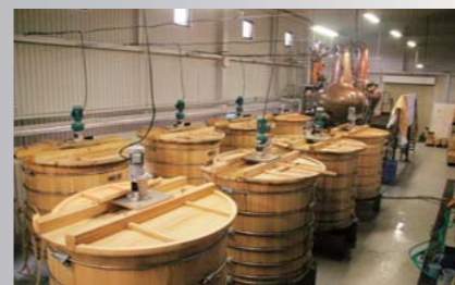
製造棟内のミズナラ製のウォッシュバックを8基設置。容量はそれぞれ約3100ℓ。複雑で華やかな味わいを生み出す。
